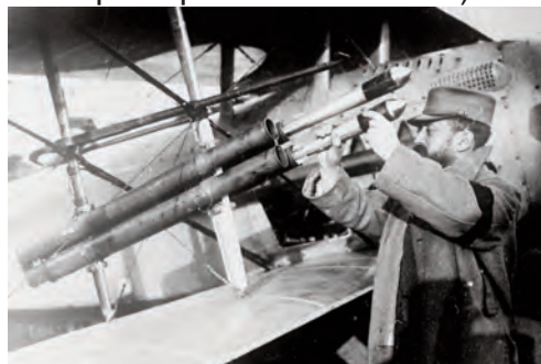
Figure 8 : SPAD XIII avec tubes lance-torpilles
